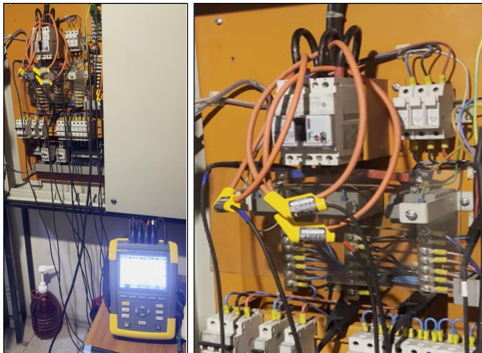
Imagen 4 – Ejemplo 1 de conexión PQA 435ii en TDAyF.
